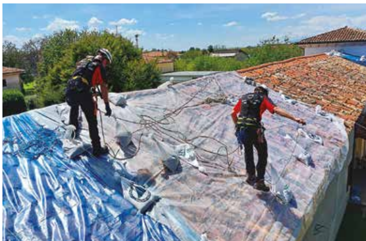
Messa in sicurezza tetti
